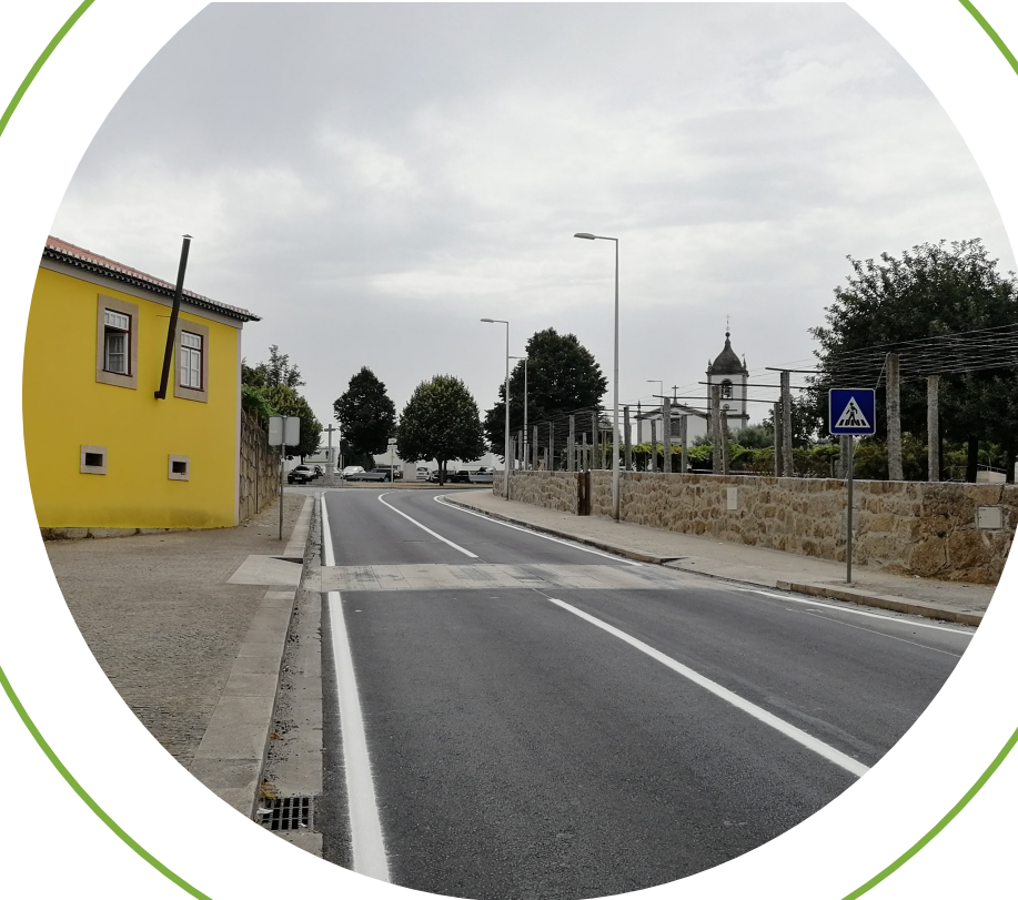
Alargamento do passeio da Avenida S. Miguel
