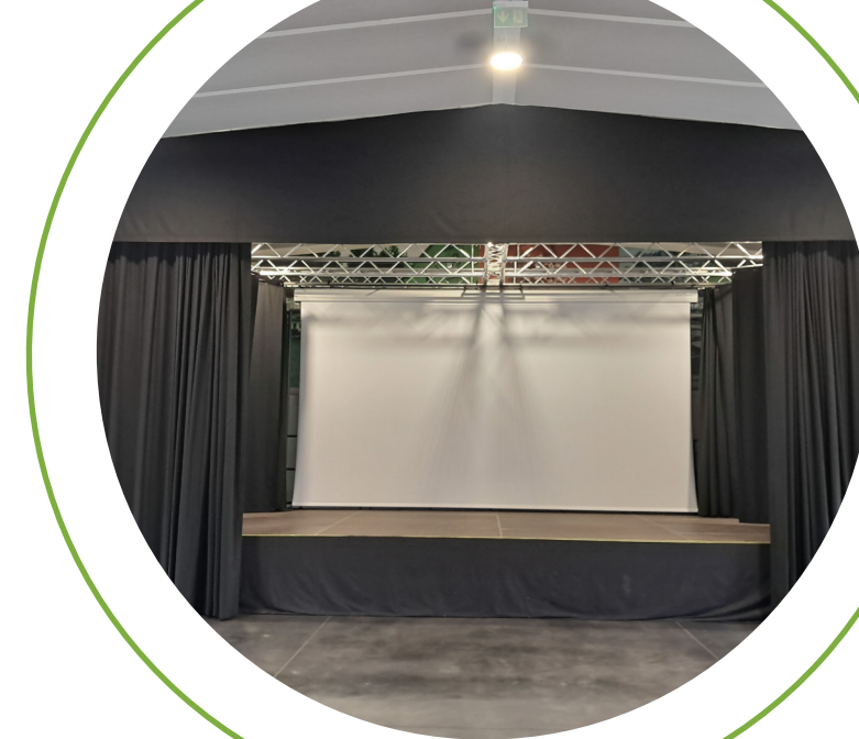
Instalação de box e equipamento cénico no Multiusos
